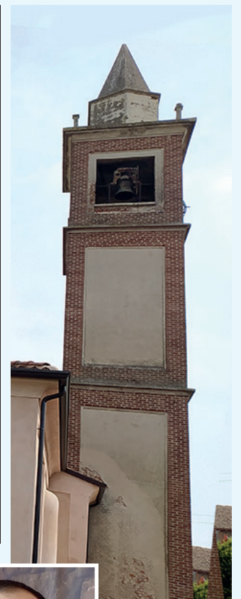
• Alberto Lodroni, vice Sindaco e Assessore ai Lavori Pubblici; sopra, il campanile della chiesa, realizzato nel 1937, dopo la demolizione del precedente del 1761 ormai pericolante.
