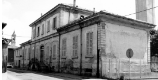
PRIMA DELL'INTERVENTO L'EDIFICIO SI PRESENTAVA COSÌ
